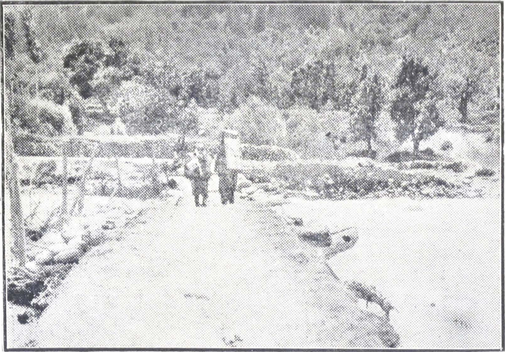
A crude bridge over the Sind River.
